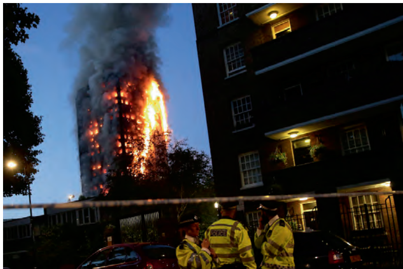
INCENDIO DELLA GRENFELL TOWER , LONDRA - 14 GIUGNO 2017
